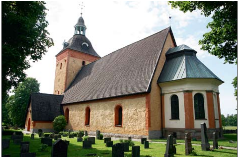
Vapenhuset, långskeppet och koret.
